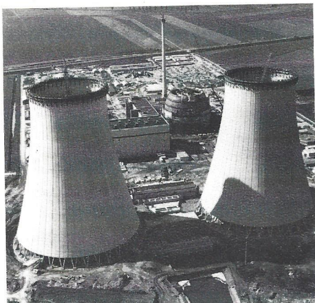
Naturzugkühler für das Kernkraftwerk Grohnde (Freigabe-Nr. 13655/81)
