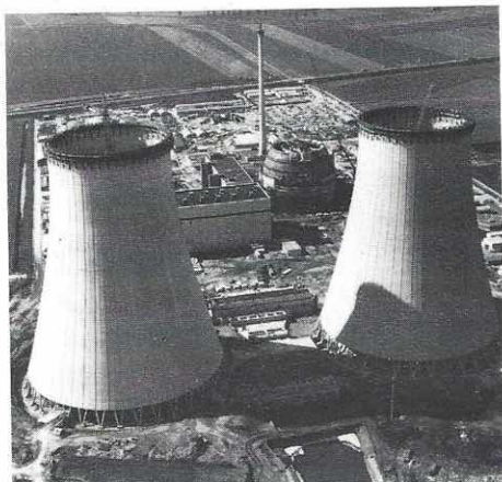
Naturzugkühler für das Kernkraftwerk Grohnde (Freigabe-Nr. 13655/81)
