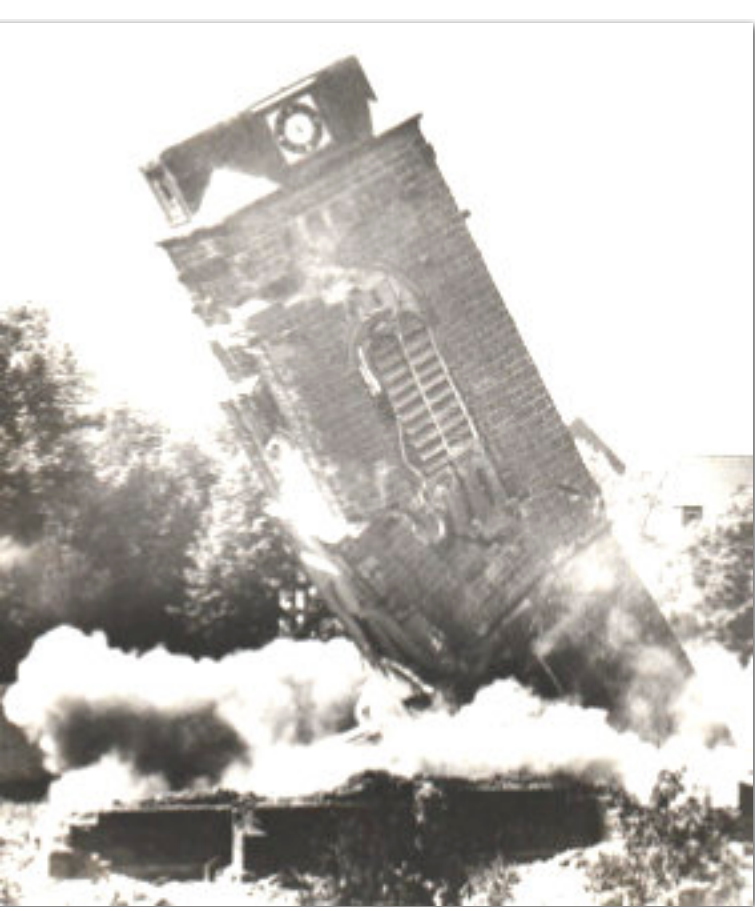
Abbruch der alten St. Joseph Kirche am 15. August 1983
