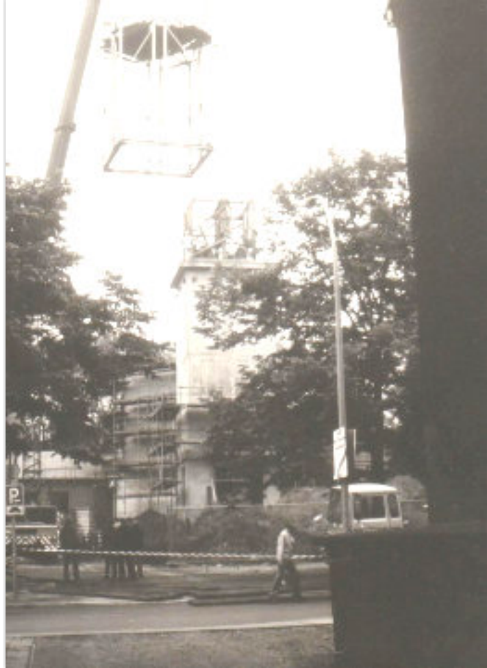
Montage des 8 Tonnen schweren Turmhelms der neuen St. Joseph Kirche am 7. Juni 1984
